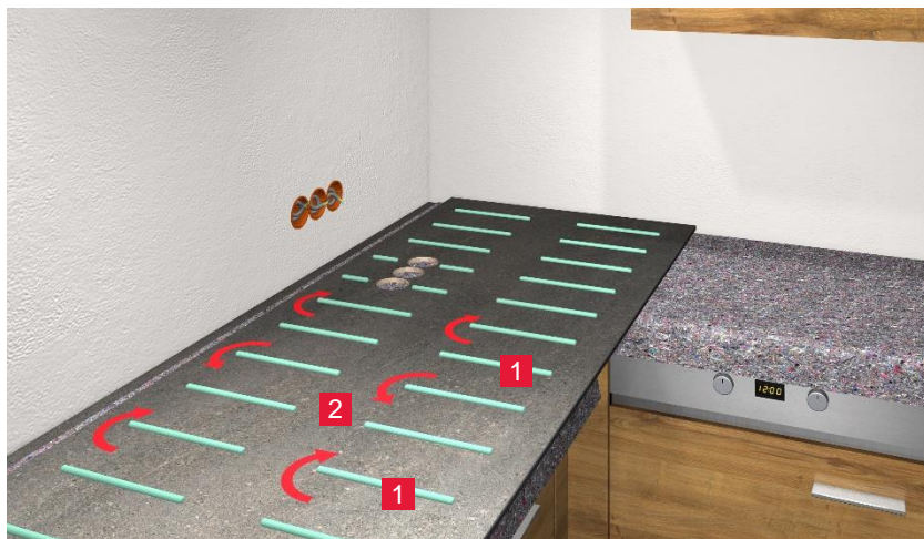
Obrázek 13: Nanášení lepidla na zádovou desku
