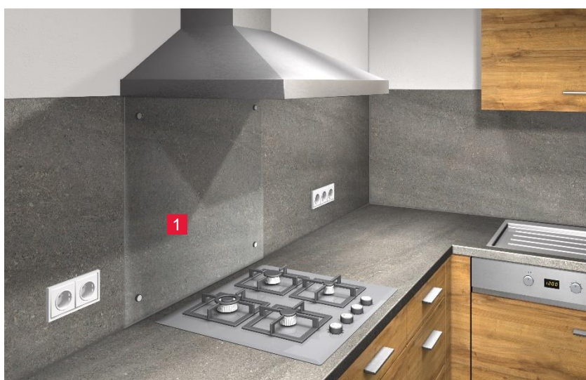
Obrázek 16: Situace v kuchyni s plynovou varnou deskou a zádovou deskou s ESG skleněnou bezpečnostní deskou
